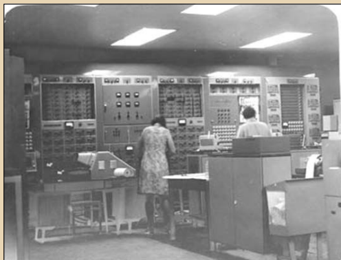
Аналого-цифровой вычислительный комплекс на базе ЭВМ «Минск-22М» и АВМ «МН-17М». Источник фото – И.И. Гурчин, О.Ф.Ковалев, «История кафедры “Электронные вычислительные машины”»
